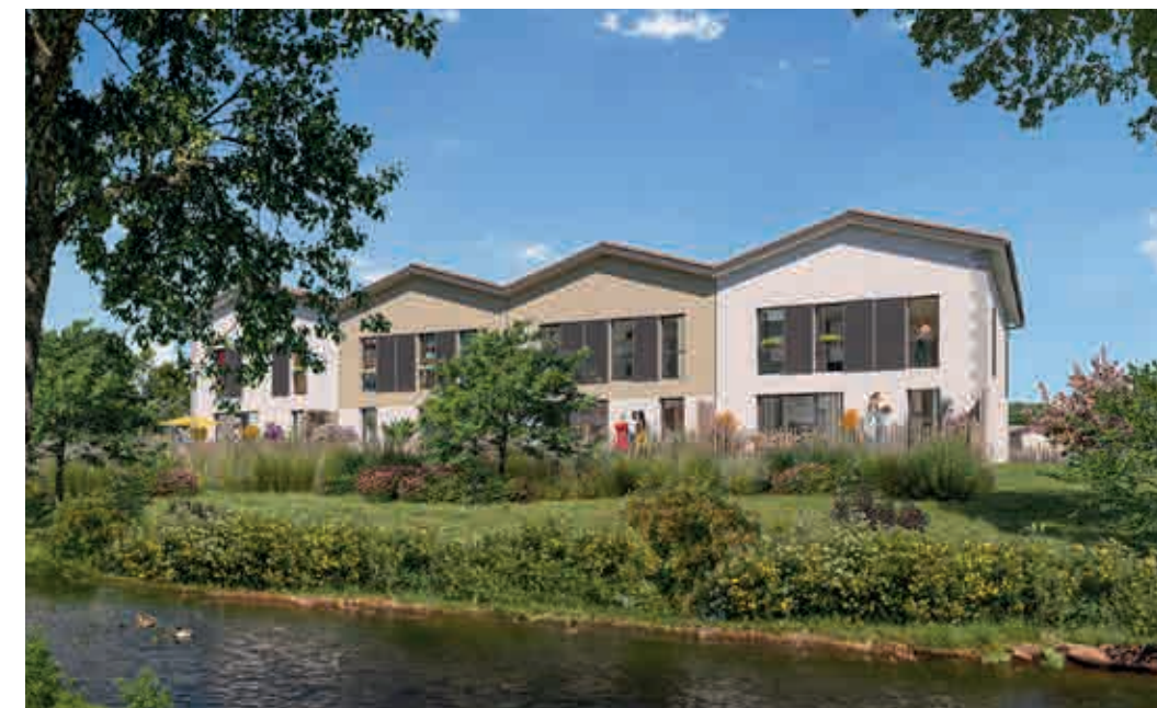
Domaine du Ruisseau à Audenge Architecte : Morand Legrix Architectes
