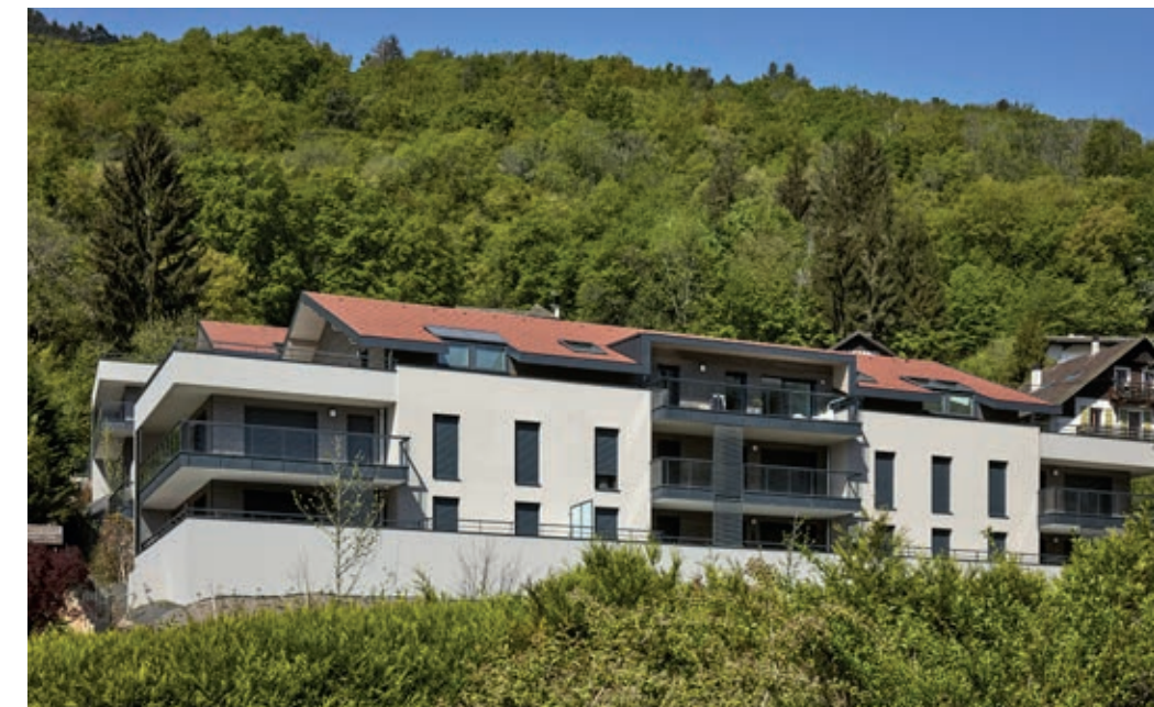
Sévrier - Les Terrasses du Lac Agence d'Architecture Yves Poncet & David Ferré
