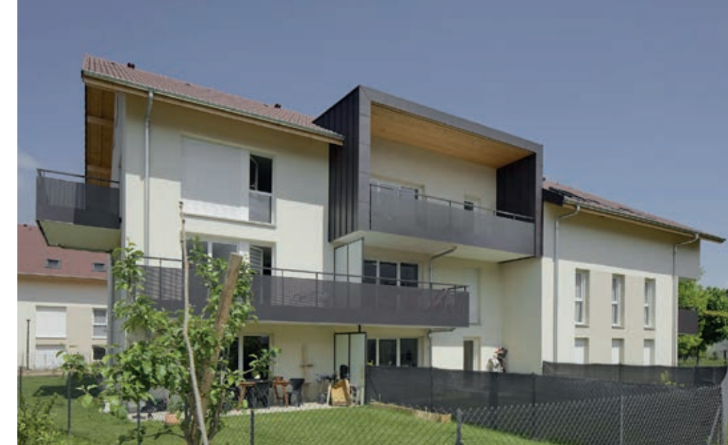
Villas Aravis - Saint-Pierre-en-Faucigny Agence d'Architecture David Ferré
