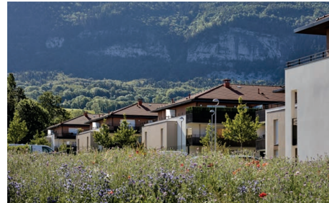
Terrasses Bellevue à Beaumont Architecte : Agence d'architecture David Ferré
