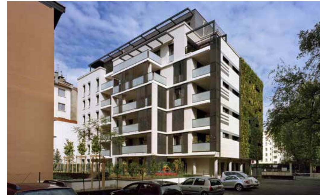
34 rue Lt. col. prévost - Lyon 6 e Architecte : Atelier Thierry Roche
