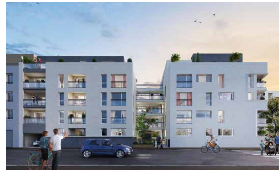
Côté 8 e - Vénissieux Architecte : Architectes Associés
