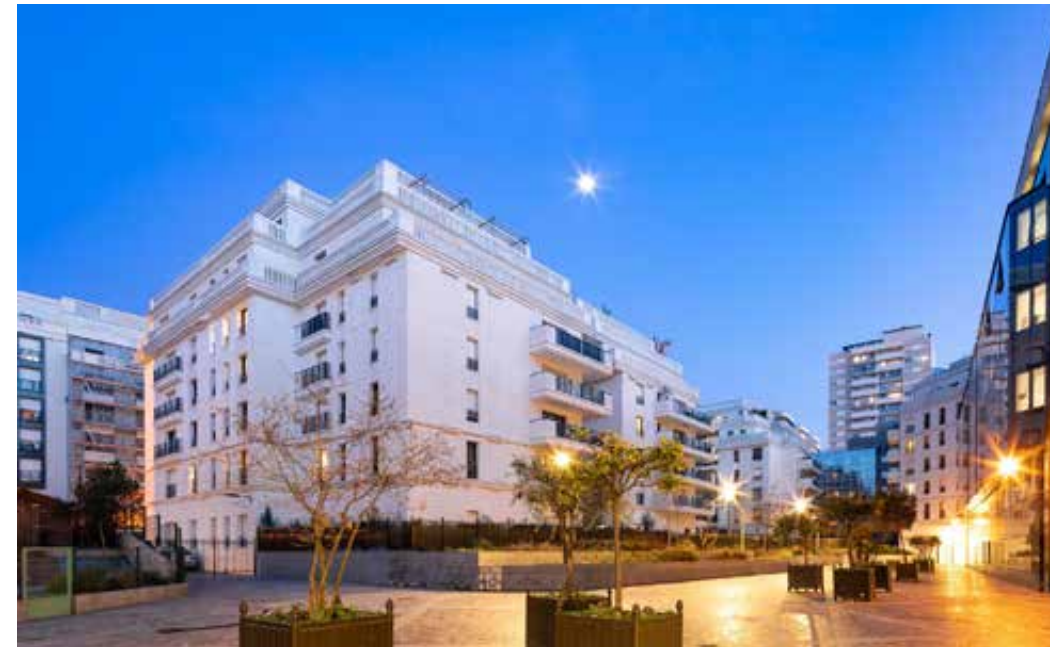
Carré Jules Vernes à Levallois-Perret Architecte : DGM & Associés
