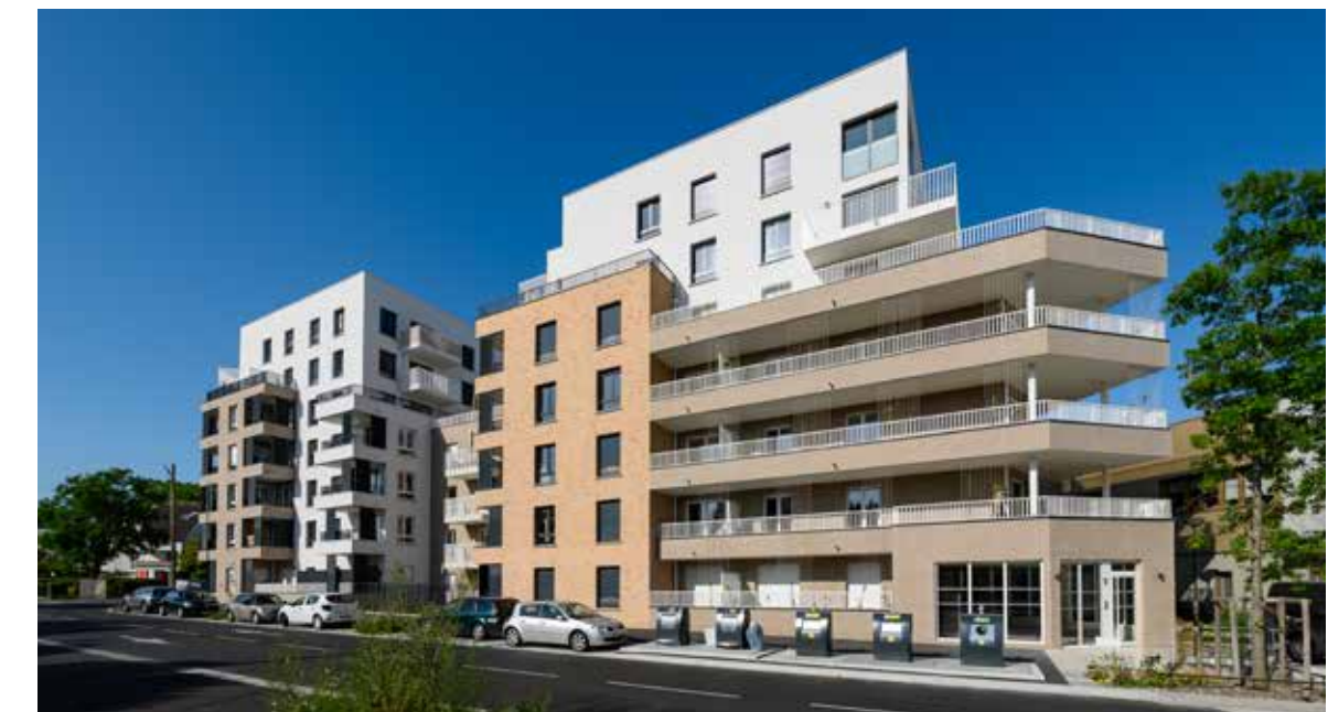
Le Domaine de la Chesnaie II à Montigny-lès-Cormeilles Architecte : Sathy Architecture
