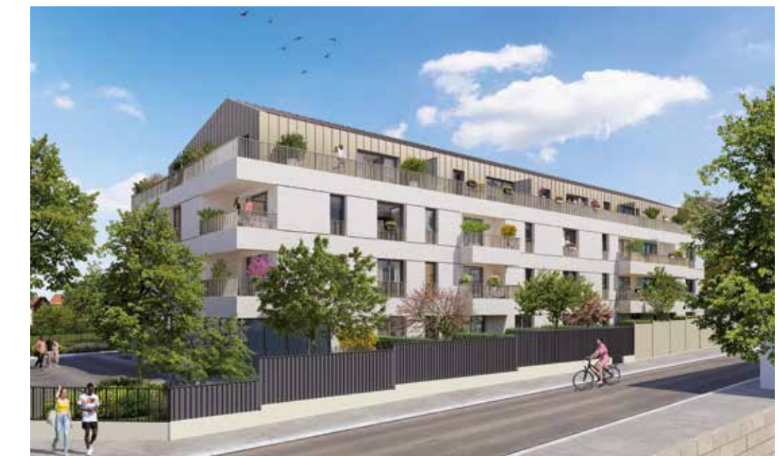
Résidence Le Coty à Ambarès-et-Lagrave (33) Architecte : M2L Architectes
