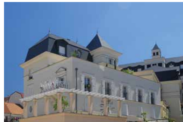
Palais Colbert - Le Plessis Robinson Architecte : BREITMAN & BREITMAN Architectes
