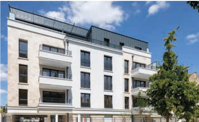
Villa Flora - Fontenay-sous-Bois Architecte : A2D Architecture
