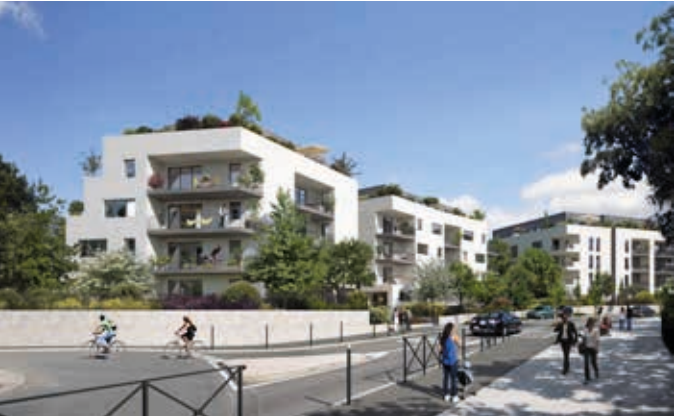
Domaine des Hirondelles - Montpellier Architecte : Serrado Architecture
