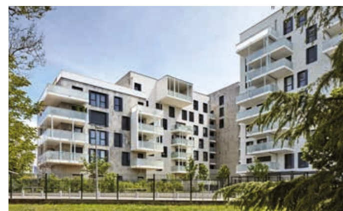
Les terrasses de l'Helvétie - Ambilly Architecte : Cabinet Oworkshop
