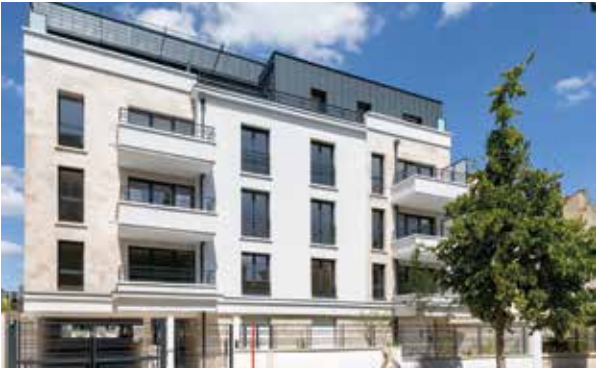
Villa Flora - Fontenay-sous-Bois Architecte : A2D Architecture
