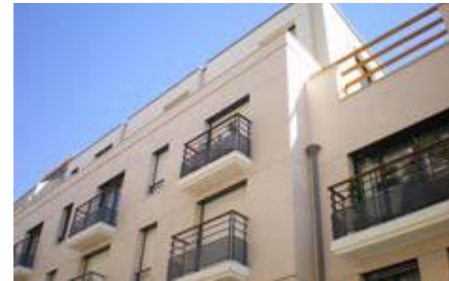
187 Aguesseau - Boulogne-Billancourt Architecte Cabinet Zandfos 2
