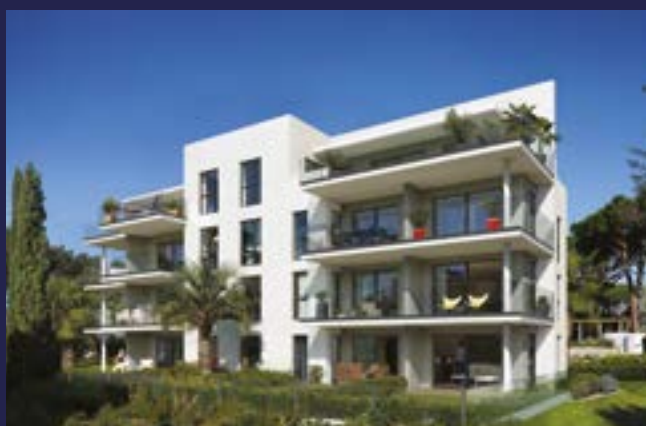
Le Panoramic - Antibes Architecte : Atelier Gosselin
