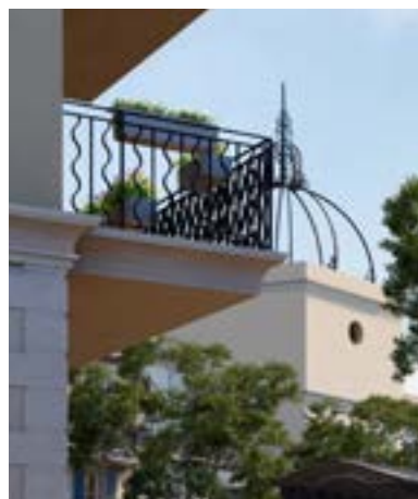
Balcons et éléments de serrurerie
