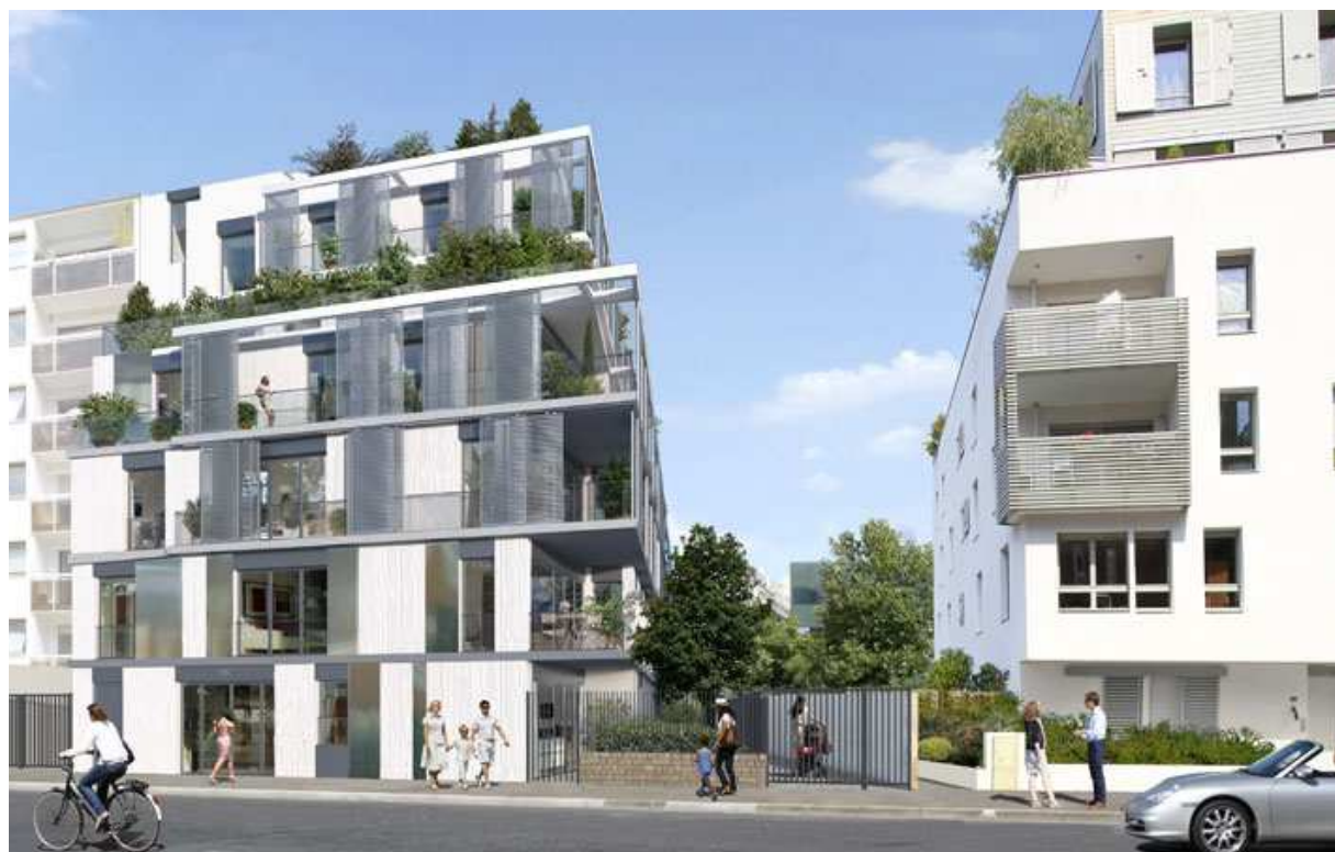
Boulogne-Billancourt (92) – 24, rue du Fief
