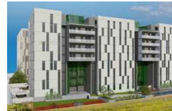
Hospitalet de Ll. «Residencial Central Park»
