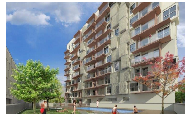
Architectes: Arata Isozaki & Asociados España y SOB
