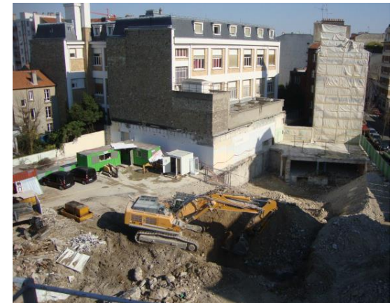
Montrouge – White (chantier)
