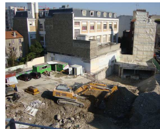
Montrouge – White (chantier)
