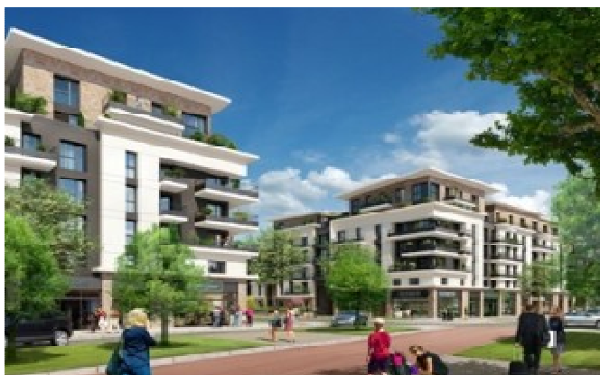
Trappes Les Terrasses de Neauphle
