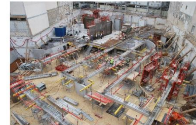
Boulogne – 50 Route de la Reine - Chantier
