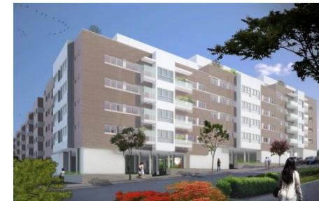
Madrid Residencia Parque Henares II
