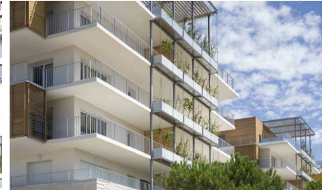
Montpellier - Architecte : Emmanuel Nebout
