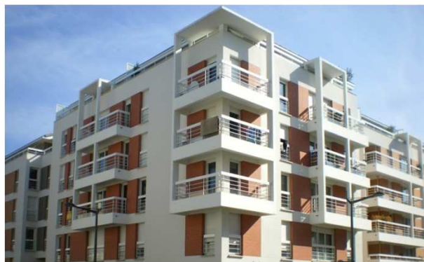
Massy - Architecte : SCGA
