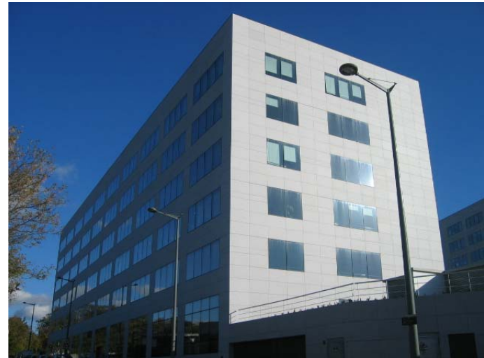
Immeuble Uranus – Le Copernic
