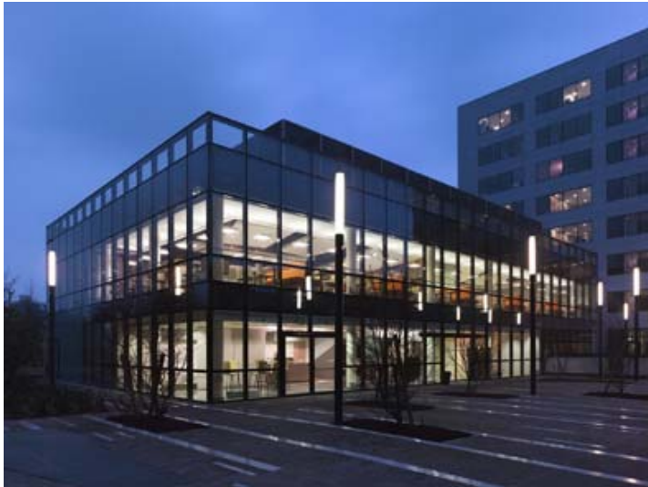
Immeuble Mercure et Bâtiment RIE – Le Copernic
