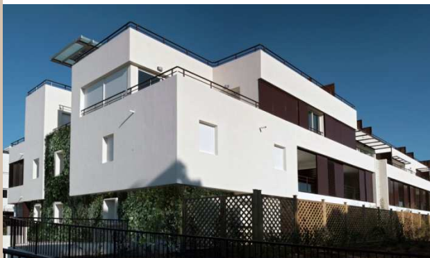
La Grande Motte - Architecte : Antoine Soler
